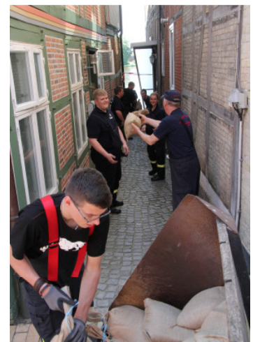
Sicherungsarbeiten in Lauenburg.
