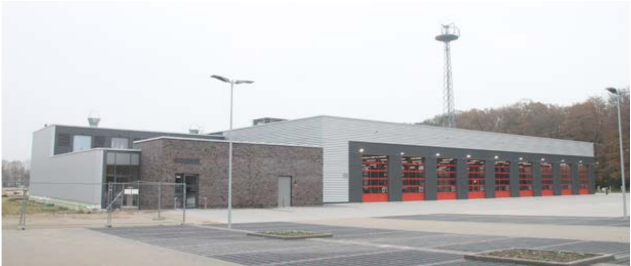
Erweiterungsbau der FTZ Pinneberg in Tornesch
