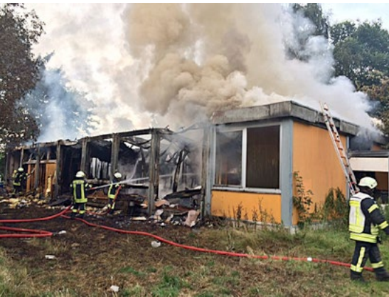
Diese Handwerkerunterkunft in Groß Wulfsfelde brannte komplett nieder.
