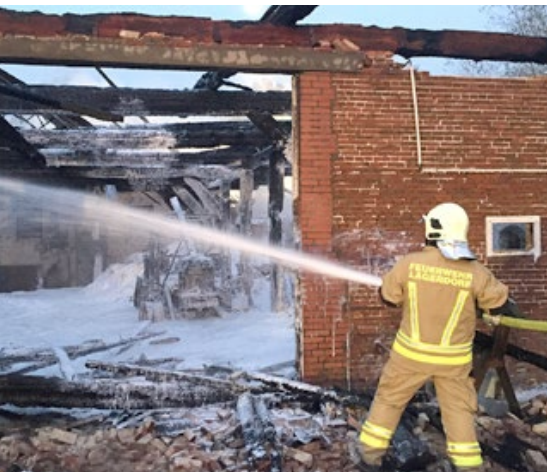
Ein Bild der Verwüstung beim Großbrand in Rethwisch
