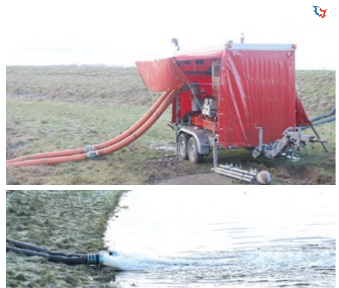
Mit Mitteln des Landes wurden vier Starkpumpen angeschafft, die sich u.a. hier beim Hochwasser in Wrist (Kreis Steinburg) erfolgreich eingesetzt wurden. Die Beschaffung von vier weiteren Pumpen soll erfolgen. Foto: Rusch
