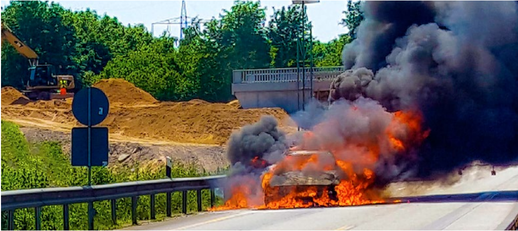
Ein PKW brannte im Baustellenbereich der A7 bei Neumünster.
