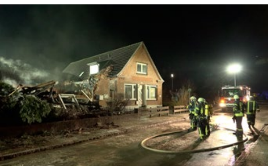
Bei einer Gasexplosion in Osterrönfeld wurde ein Wohnhaus komplett zerstört.
