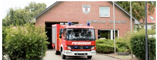
Das Gerätehaus in Schürsdorf wird neu gebaut.
