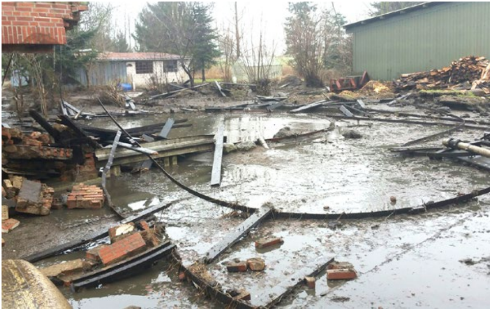
Der Güllebehälter wurde vollständig zerstört.
