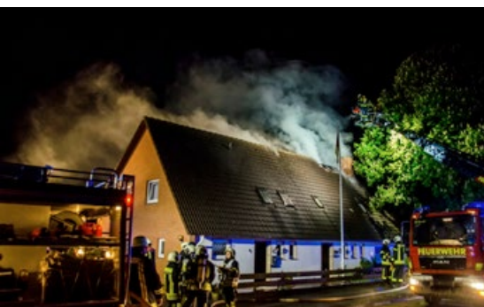
Feuer und Rauch machten dieses Haus in der Gemeinde Grömitz unbewohnbar
