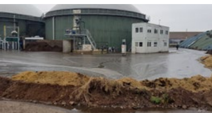
In Brokenlande havarierte eine Biogasanlage. Erdwälle verhinderten die Ausbreitung der Gülle.
