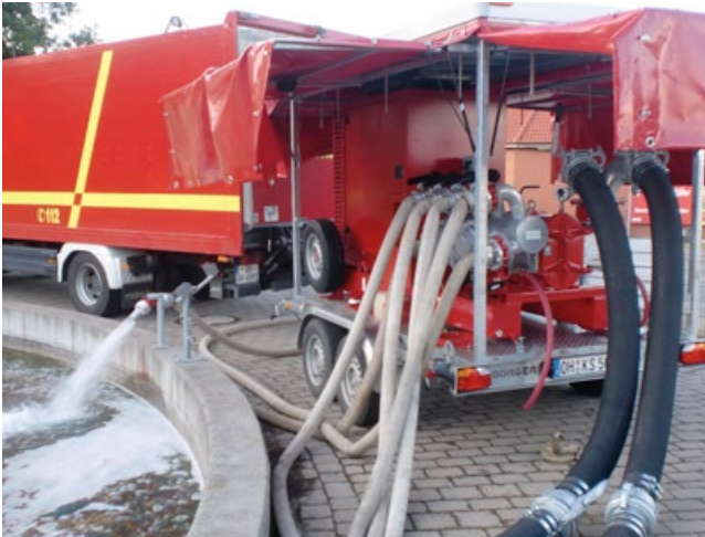
Hochleistungspumpen wie diese kommen beim Katastrophenschutztag in Rendsburg zum Einsatz.
