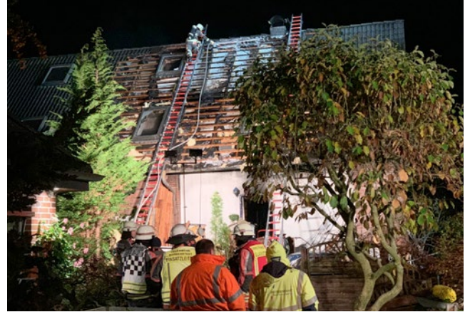
In Norderstedt brannte ein Einfamilienhaus nieder.
