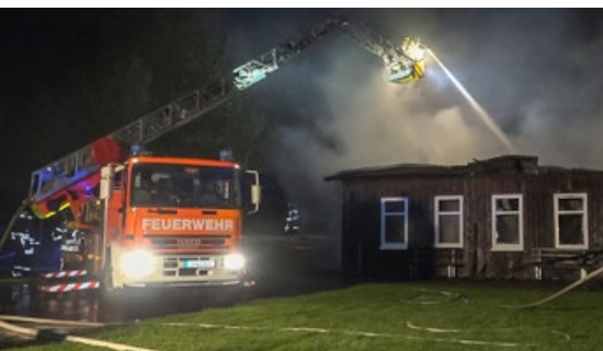
Das Schützenheim in Bujendorf wurde ein Raub der Flammen.
