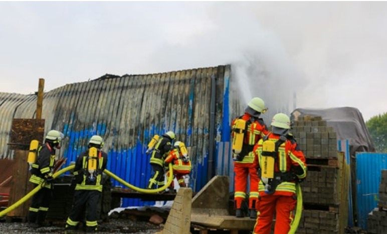
Bei dem Feuer in Osterrönfeld mussten Wände geöffnet werden, um an das Feuer zu kommen.
