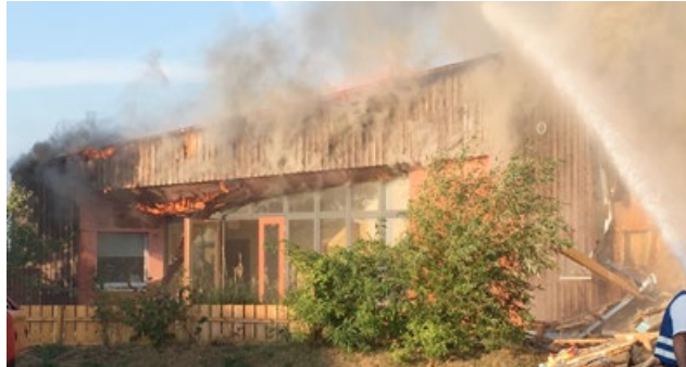
In Wöhrden brannte ein Kindergarten restlos nieder. Die Wasserversorgung war dramatisch.
