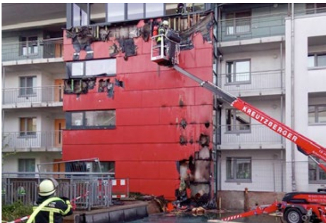
Bei diesem Fassadenbrand in Kiel ließ sich die Feuerwehr eine Hubarbeitsbühne
