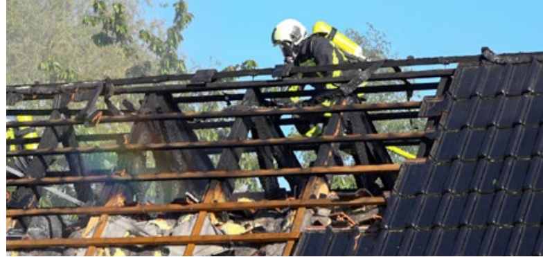
In Ahrensbök brannte der Dachstuhl eines Mehrfamilienhauses.
