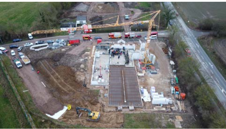
Die Ausmasse des neuen Feuerwehrhauses in Stockelsdorf sind bereits zu erkennen.
