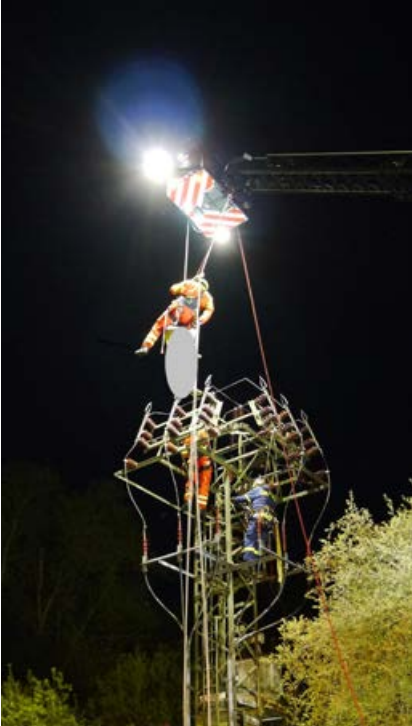
Rettung mit der Drehleiter am Hochspannungsmast.
