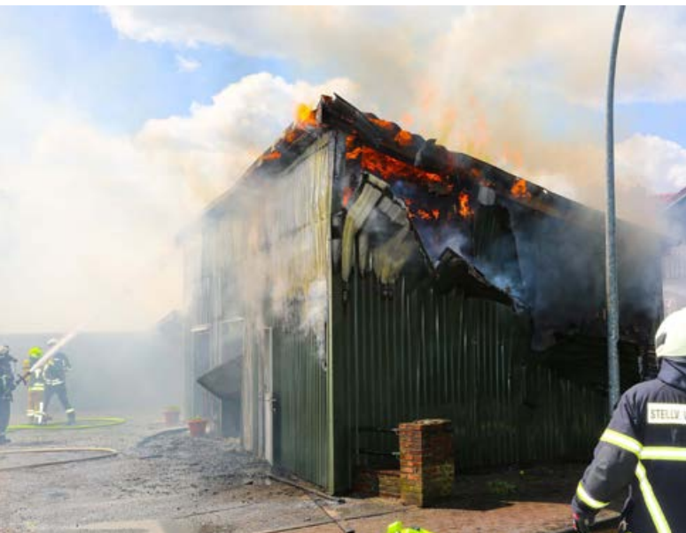
In Wasbek brannte dieser Maschinenschuppen.
