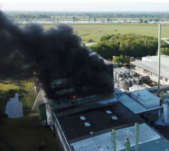
Eine mehrere hundert Meter hohe Rauchsäule stand über der Chemiefabrik in Lauenburg.
