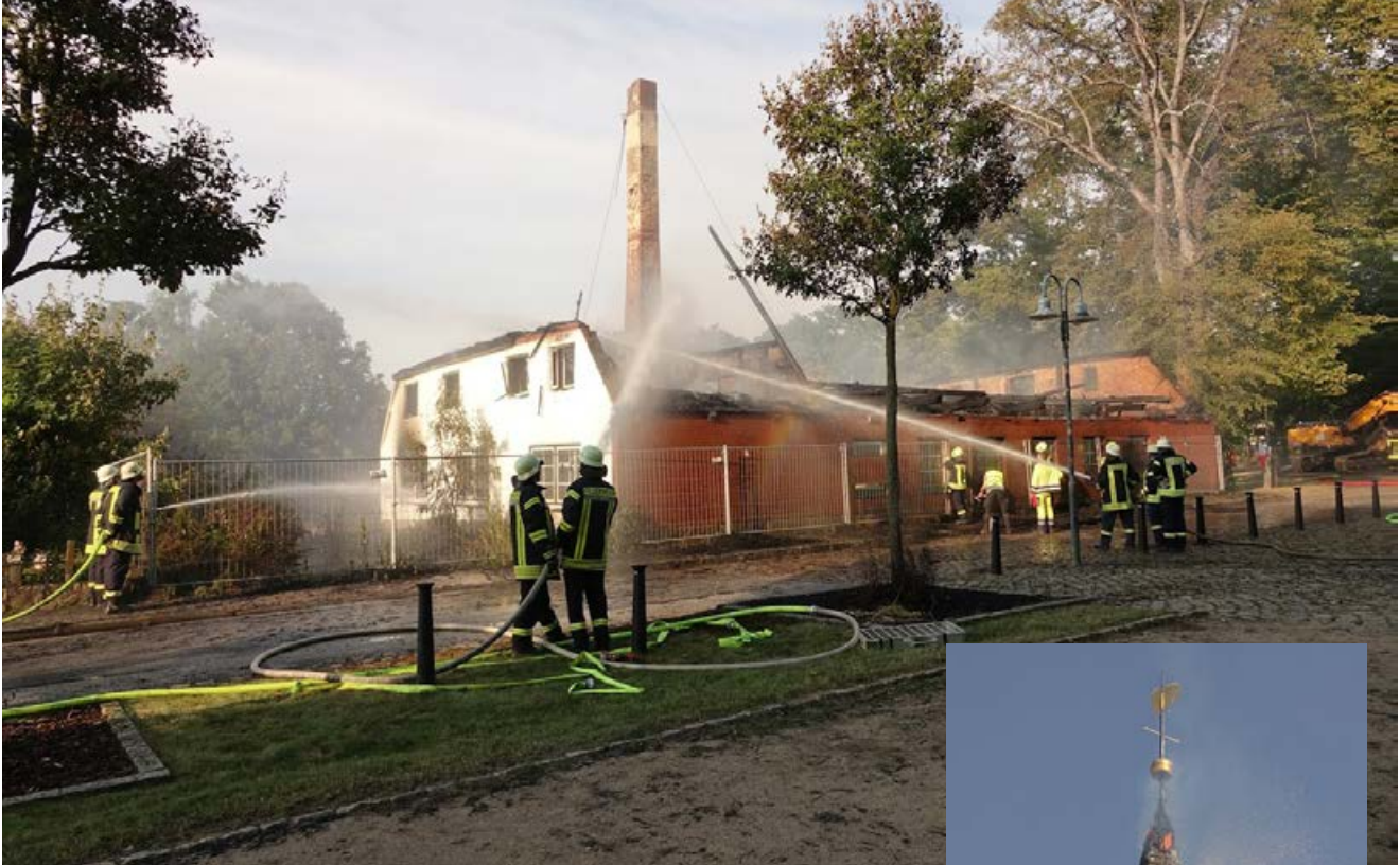
Vom ehemaligen Gasthof in Brügge blieben nur Trümmer.
