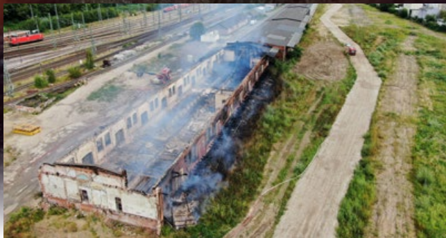
Am Tag danach wird das Ausmass der Zerstörung deutlich.
