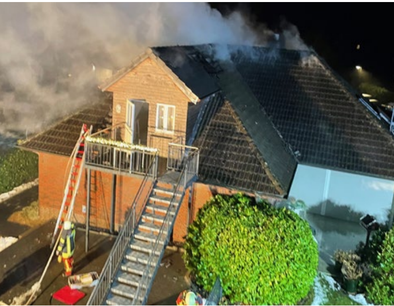
Ein Dachstuhlbrand in einer Ferienwohnung in Scharbeutz forderte die Feuerwehr.
