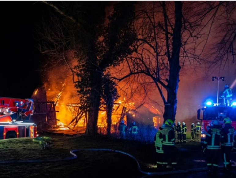
Eine Lagerhalle in Zarnekau brannte komplett nieder.
