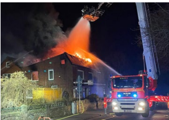
In Hamdorf wurde ein Wohngebäude völlig vernichtet.
