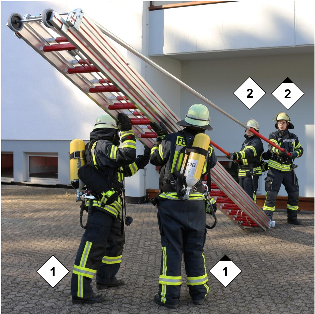
Abbildung 22: Aufrichten der Schiebleiter
