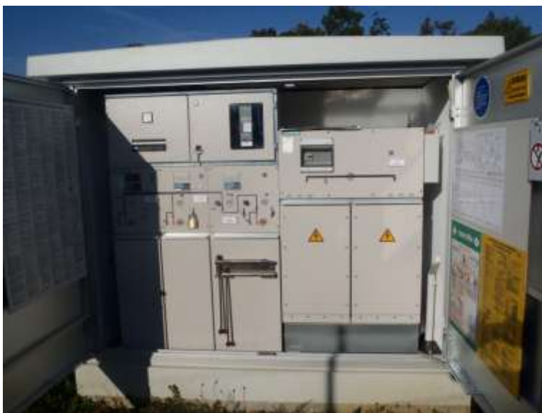
Bild 5-41: Mittelspannungsschaltstation
