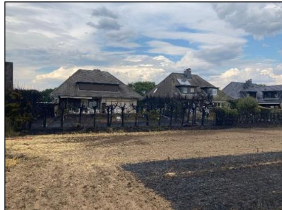
Abbildung 19 Beschädigung der Wohngebäude durch thermische Einwirkung
