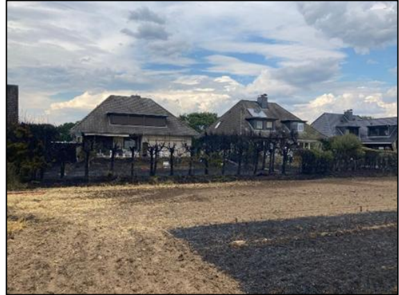
Abbildung 19 Beschädigung der Wohngebäude durch thermische Einwirkung
