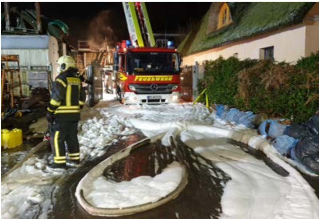
Bei diesem Brand in Aumühle war die Lageerkundung durch bauliche Gegebenheiten erst schwierig.
